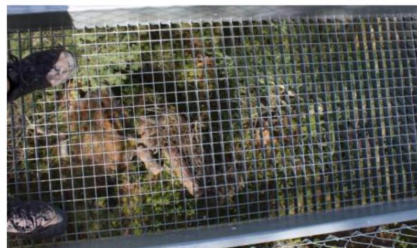
Gitterrost 33 x 33 mm, mit Gleitschutz
