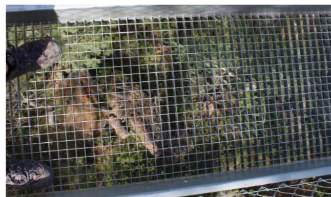
Gitterrost 33 x 33 mm, mit Gleitschutz
