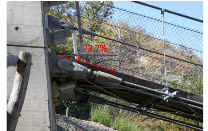
Detailansicht ponte tibetano Carasc; max. Steigung 23.7%
