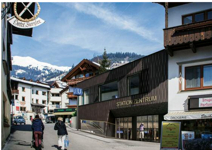
Eingang zur U-Bahn im Zentrum von Serfaus.
