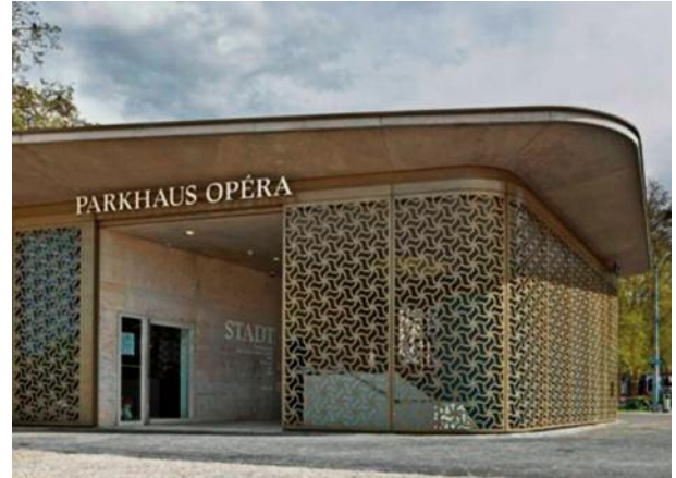
Parkhaus Opéra in Zürich. Zugang auf dem Sechseläutenplatz.
